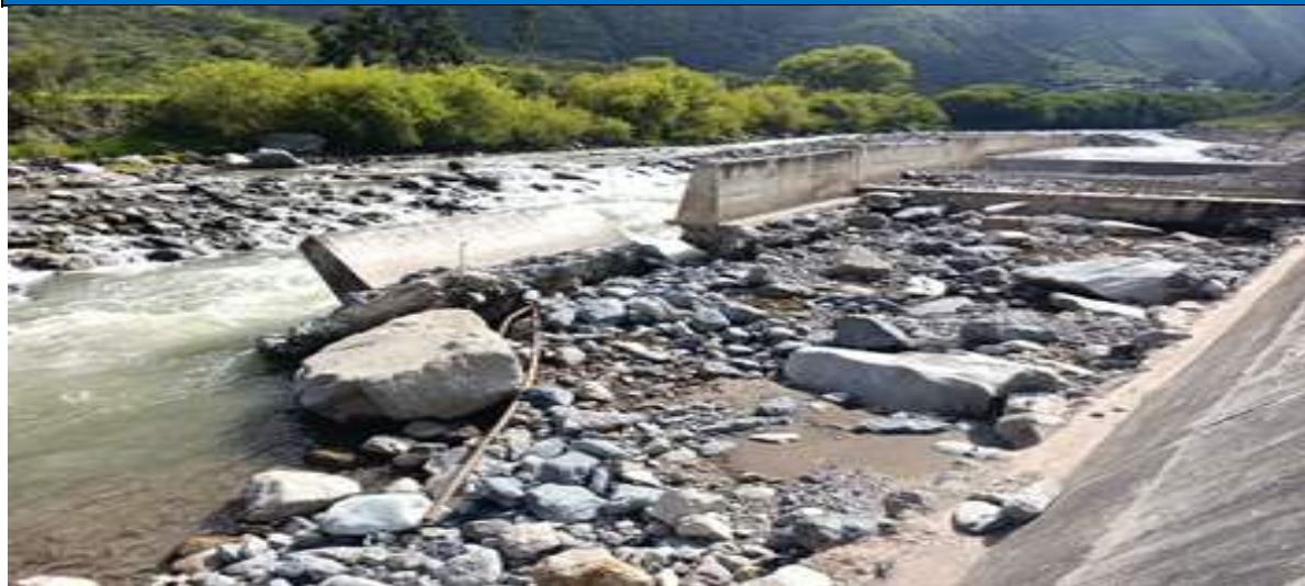
FOTOGRAFIA N°01: TRAMO CRÍTICO EN EL RÍO CHIRIS MARGEN IZQUIERDA, SE ENCUENTRA EXPUESTA A PELIGRO LA BOCATOMA DEL CANAL PRINCIPAL DE TICRAO POR LO SE REQUIERE DE ATENCION URGENTE
