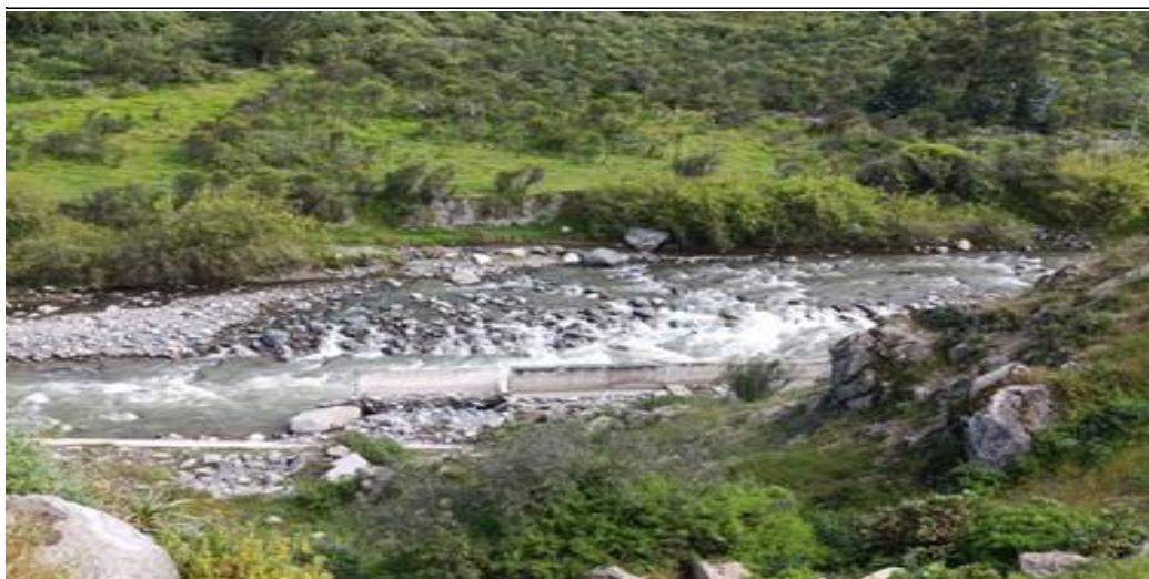
FOTOGRAFIA N°02: TRAMO CRÍTICO EN EL RÍO CHIRIS MARGEN IZQUIERDA SE ENCUENTRA SOCAVADA LA DEFENSA RIBEREÑA EXISTENTE Y EXPUESTO A PELIGRO EL CANAL PRINCIPAL DE TICRAPO.
